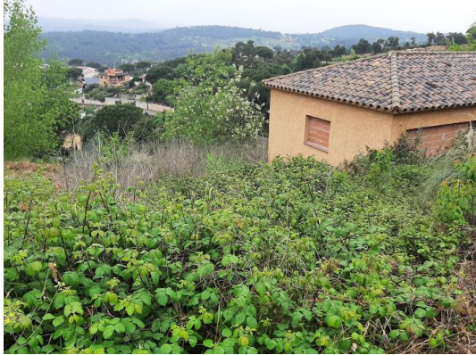
Parcel·la edificada amb excés de vegetació
