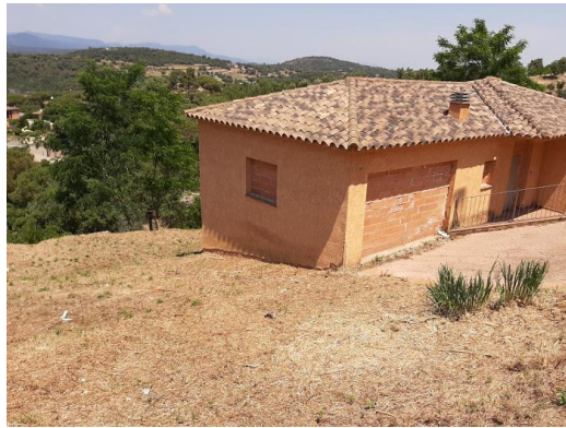
Parcel·la edificada en correcte estat
