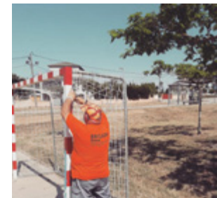
Millores i canvi de mobiliari a la Zona Esportiva de Maçanet Residencial Park
