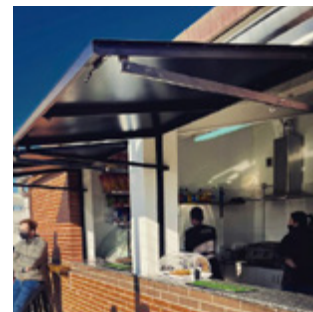
Obertura de la Consergeria del Camp de Futbol Municipal
