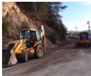
Millores al camí de l'Estació Maçanet - Massanes
